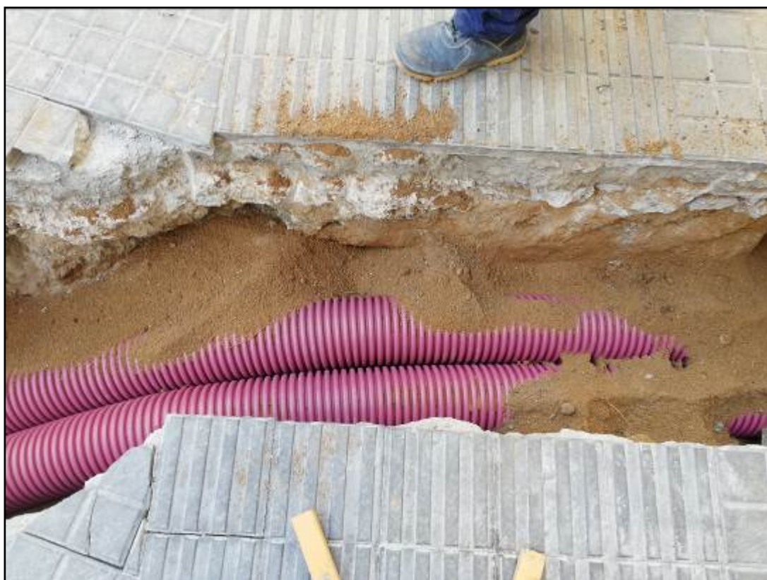
Fotografia 8. Col·locació de tubs per xarxa elèctrica.
