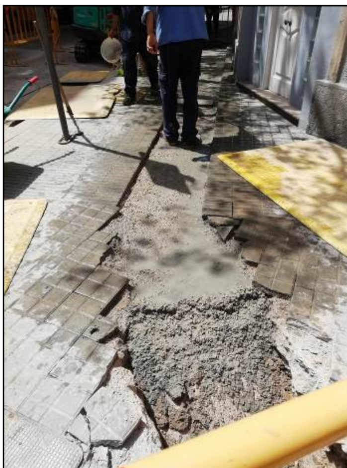
Fotografia 10. Pavimentació de la rasa
