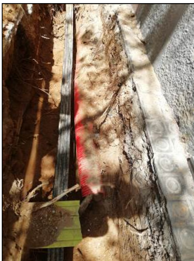
Fotografia 6. Altra tram de la rasa un cop fet el buidatge on es pot veure els serveis que es trobaven en aquesta zona.
