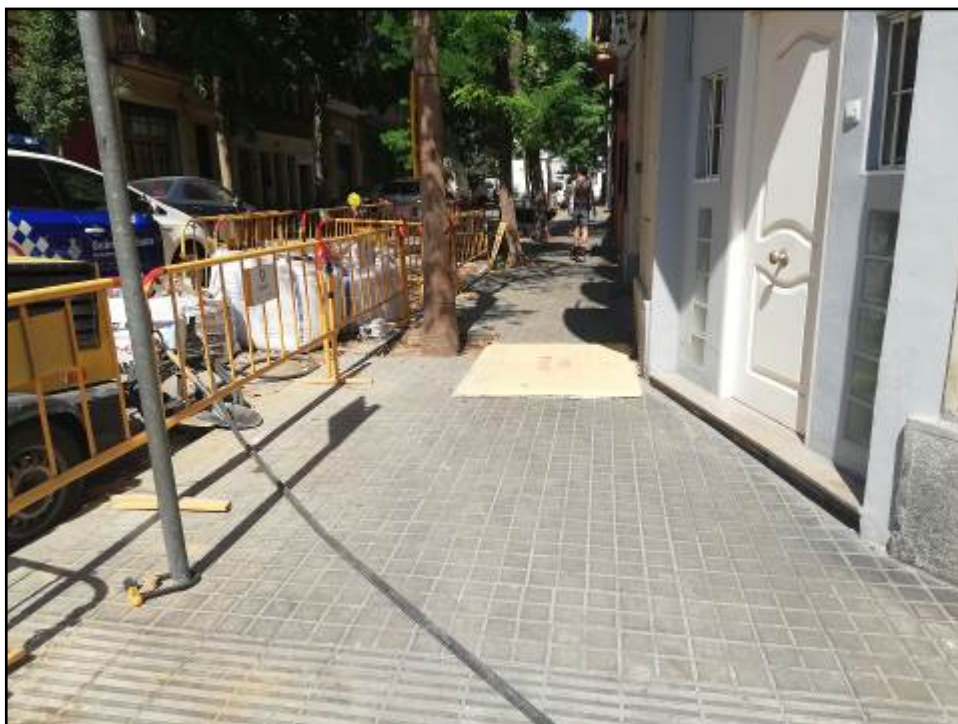
Fotografia 1. Detall del Carrer Piquer abans de començar els treballs.
