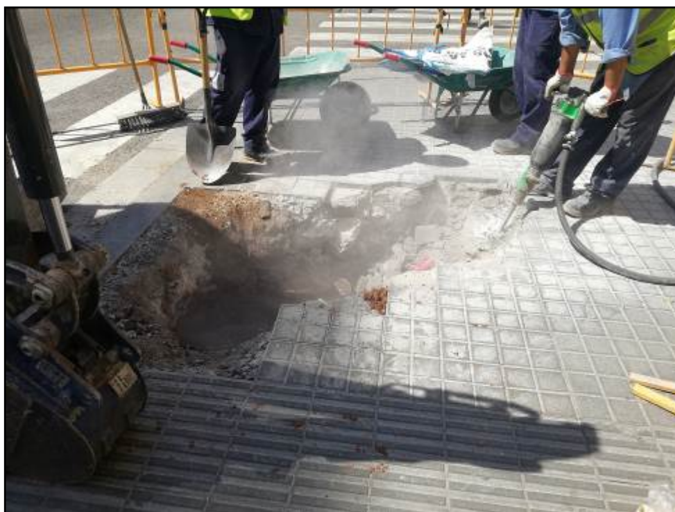
Fotografia 2. Obertura de la Rasa amb martell pneumàtic
