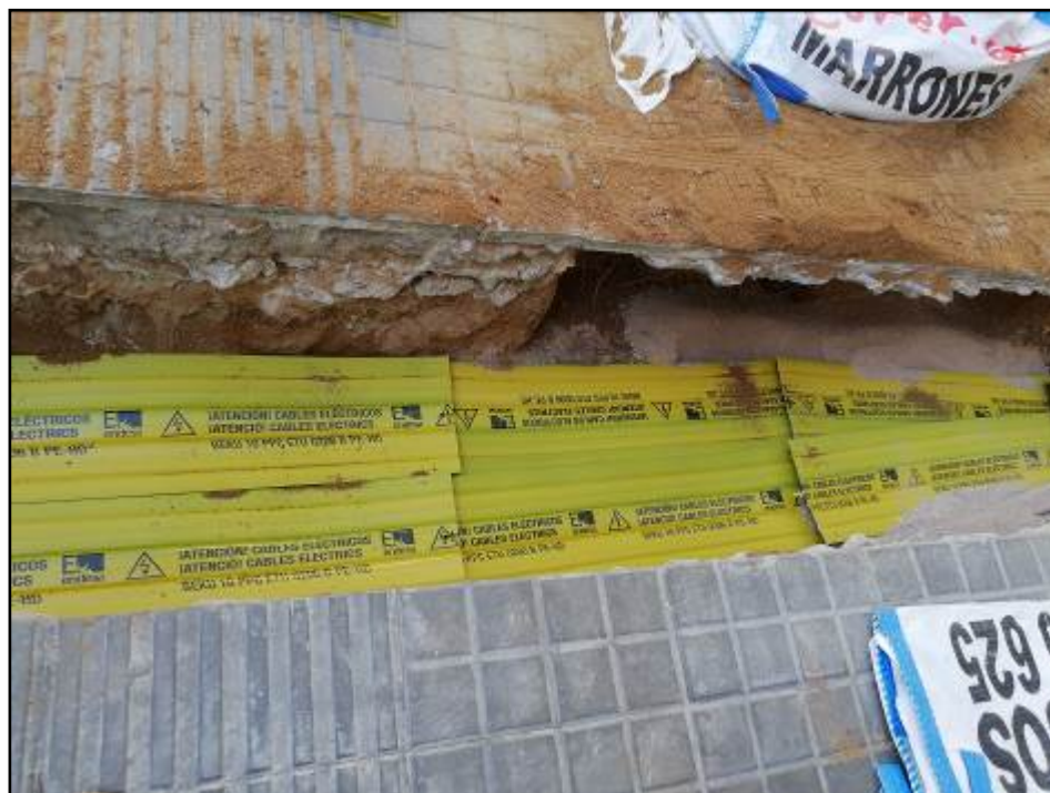
Fotografia 9. Cobriment del nou cablejat elèctric
