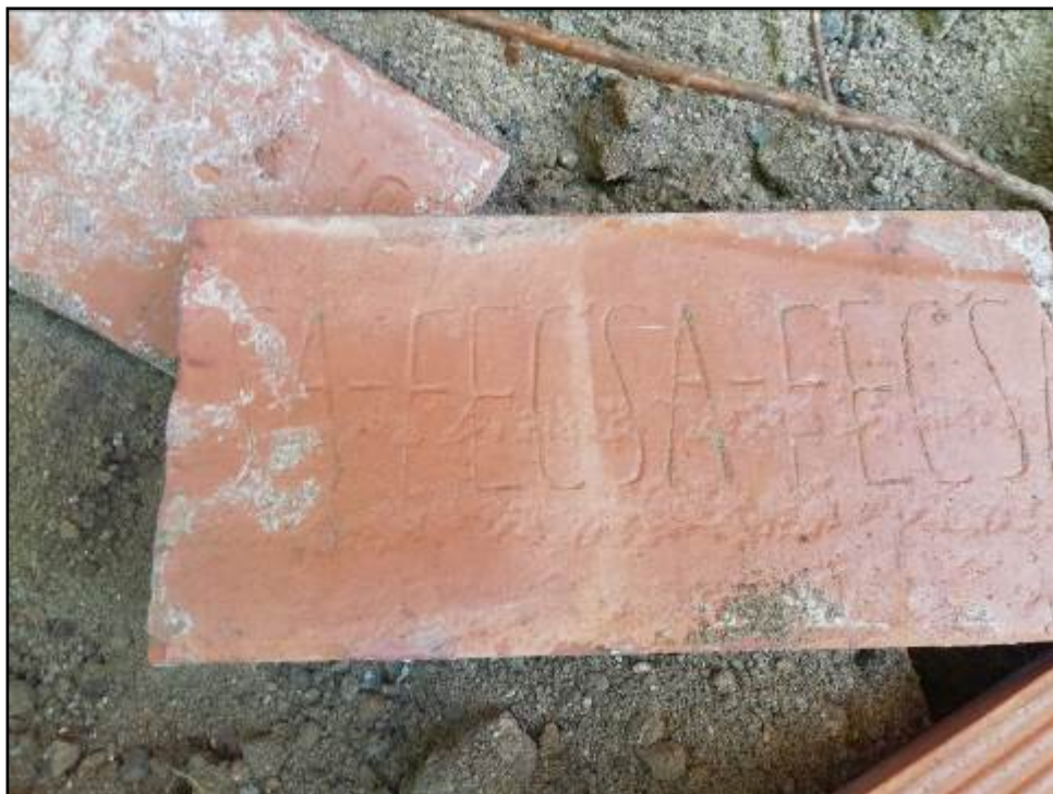
Fotografia 7. Presència de cablejat elèctric anterior.
