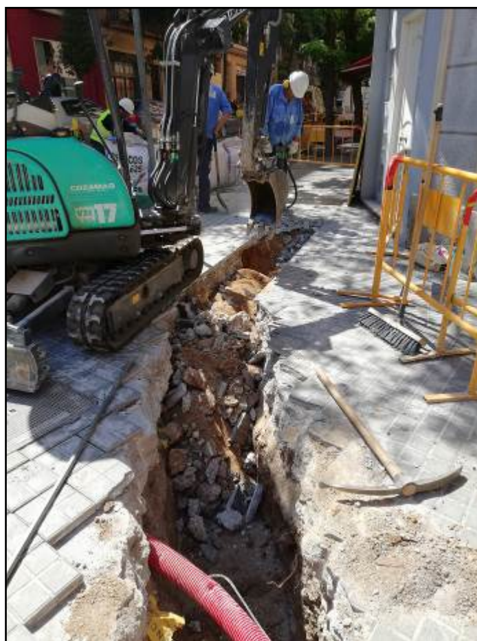
Fotografia 4. Detall dels treballs realitzats.
